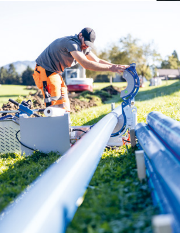
Jedes Jahr werden rund 1.5% der Wasserleitungen durch die Thurwerke AG ersetzt.
